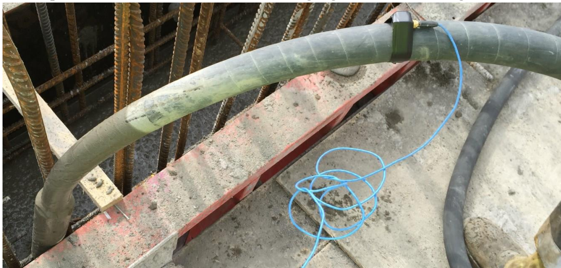
FIGUR 9. Sensor placerad 50 cm från vibrohuvudet på en väggstav [50].
