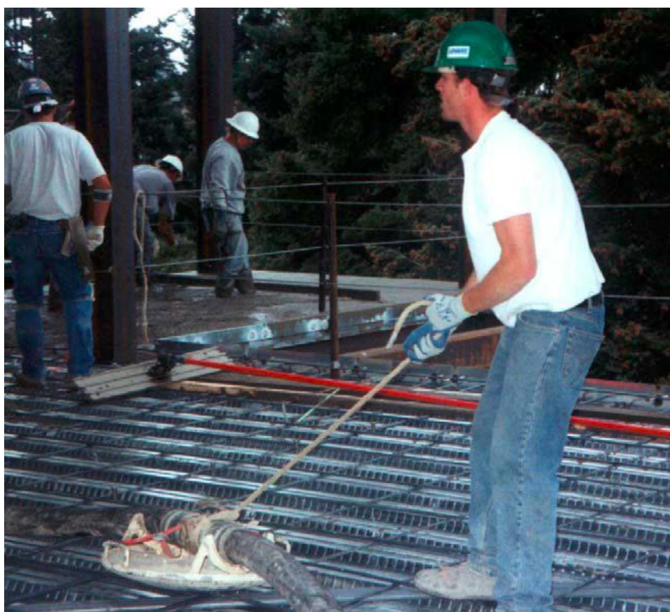
FIGUR 6. Betongarbetare som drar en betongfylld pumpslang, fixerad vid en glidplatta.
